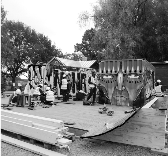
Kaupunkitutkimukseen on yhdistynyt monessa hankkeessa toimintatutkimus. Tässä rakennetaan saunaa yhdessä hollantilaisten arkkitehtipiskelijöiden kanssa Tampereen Hiedanrantaan 2019. Kuva Veera Turku.
