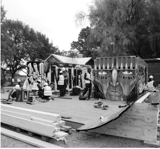
Kaupunkitutkimukseen on yhdistynyt monessa hankkeessa toimintatutkimus. Tässä rakennetaan saunaa yhdessä hollantilaisten arkkitehtiopiskelijoiden kanssa Tampereen Hiedanrantaan 2019. Kuva Veera Turku.
