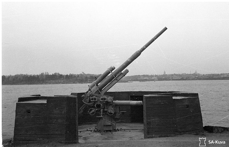
Kuva 4a. Esimerkkikuvat, klusteri 1: SA-kuva 153704: ”68.Rask.It.Ptri. Tykkien betoniset suojavarustukset. Kuvassa on saksalainen 88 mm:n raskas ilmatorjuntatykki vuodelta 1937 (88 ItK 37 RMB).” (Lähde: FINNA).
