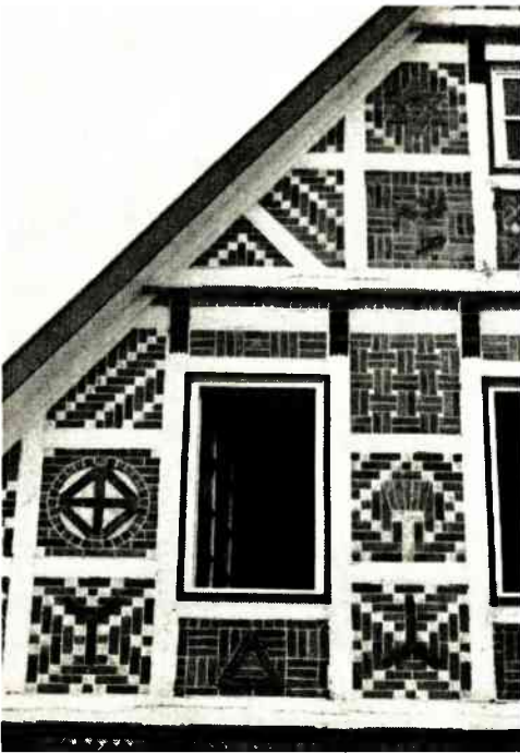
Alteslandilaisen hallitalon fasadissa on usein varausmerkkejä, joista "ukkosluuta" (oikealla toinen alhaalta) toistuu useimmissa taloissa. Sen tehtävänä oli suojella taloa salamaniskulta ja tulipalolta sekä pahoilta hengiltä (Kuva Atländer Bilderbuch 1993, 90) 22
