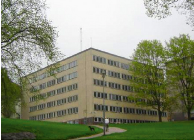
Kuva 82. Ilmatieteen laitoksen päärakennus Sääntalo, joka valmistui vuonna 1966. Laitos muutti vuonna 2005 Kumpulaan yliopistokampukselle uuteen toimitaloon Dynamicumiin, jolloin Sääntalo jäi muuhun käyttöön. Sääntalon purkutyöt aloitettiin vuoden 2021 alussa. Rakennuksen katolla näkyy tuulimittarin masto (Kuva: Heikki Nevanlinna).
