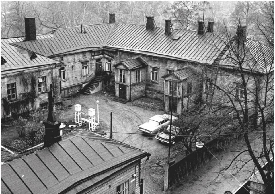
Kuva 79. Ilmatieteellisen keskuslaitoksen päärakennus 1960-luvun alussa noin 120 vuoden iässä. Huonokuntoinen rakennus purettiin vuonna 1963. Sen tilalle valmistui vuonna 1966 "Säätalo", missä Ilmatieteen laitos toimi vuoteen 2005 saakka, jolloin laitos siirtyi Kumpulaan yliopistokampukselle uuteen Dynamicum-rakennukseen. Säätaloa ollaan purkamassa vuoden 2020 aikana. (Kuva: Ilmatieteen laitos).
