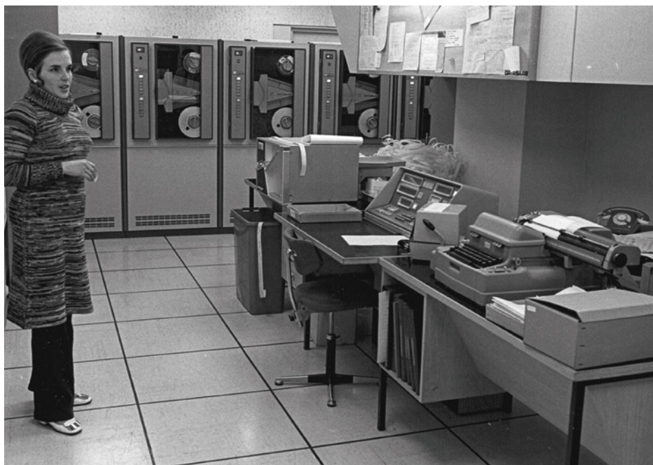
Kuva 85. Ilmatieteen laitoksen ensimmäisen tietokoneen Datasaab D21:n konsoli ja magneettinauha-asetat vuodelta 1971 Säätalossa. Ajet käynnistettiin ohjausreikänauluilla ja massamuistina oli aluksi vain magneettinauhat. Muistia oli 60 kilosanaa. Kuvassa on atk-operaattori Hilikka Valkovuori (1943–) (Kuva: Ilmatieteen laitos).
