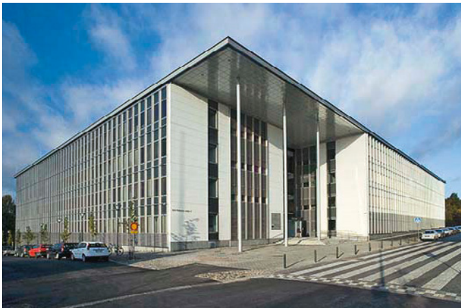
Kuva 84. Ilmatieteen laitoksen toimitalo Dynamicum Kumpulassa Helsingin yliopiston kampusalueella. Rakennus valmistui vuonna 2005. Vuonna 2020 siellä työskenteli noin 700 henkilöä. (Kuva: Ilmatieteen laitos).
