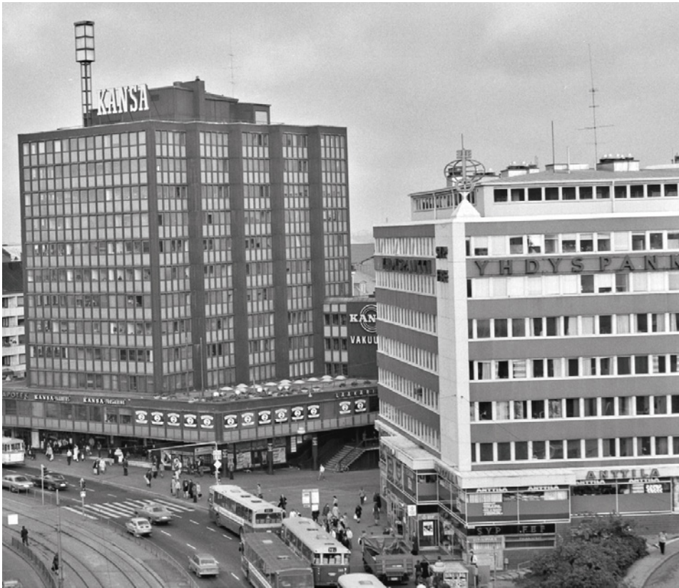
Kuva 80. Oikealla Hämeentie 31 toimistorakennus, missä suuri osa Ilmatieteen laitoksen yksiköistä toimi tilapäisesti 1961–1966. Vasemmalla Kanssa-yhtiön toimitalo. Sen katolla oli säätorni vallitsevan säätilan merkkipaaluna. Kuva on vuodelta 1981 (Kuva: Museovirasto).
