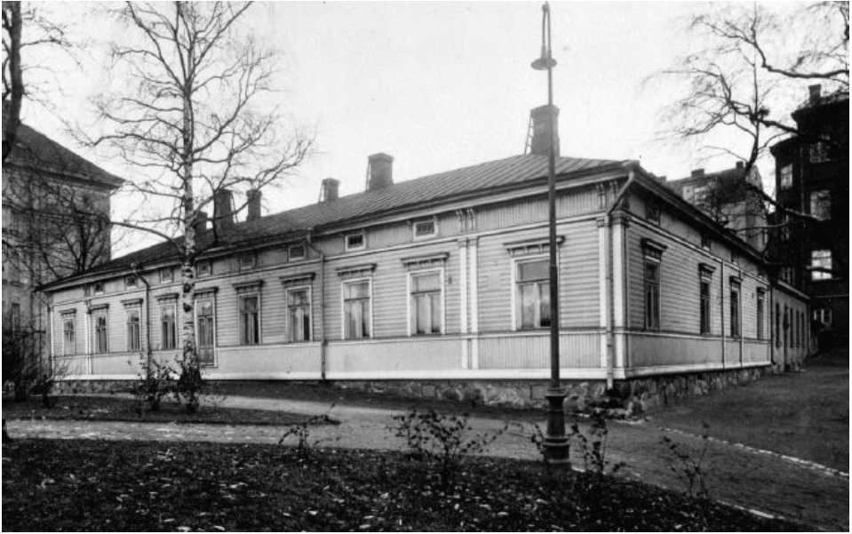
Kuva 22. Ilmatieteellisen keskuslaitoksen päärakennuksen pohjois- ja länsipääty Kaisaniemessä noin vuonna 1930. Rakennus valmistui vuonna 1841 ja on kuvassa suunnilleen alkuperäisessä tilassa. Talo oli alunperin magneettisen observatorion havainto- ja asuinrakennus. Se purettiin vuonna 1963 ja tilalle rakennettiin Ilmatieteen laitoksen toimitalo niin sanottu Säätälo, joka otettiin käyttöön vuonna 1966. Kuvan vasemmassa nurkassa näkyy osa Kaisaniemen kansakoulun päädyestä.
