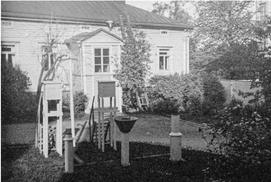
Kuva 94. Säähavaintoasema Meteorologisen keskuslaitoksen pihalla Helsingin Kaisaniemessä vuonna 1927. Etualalla on kolme erilaista sadevesimittarien keräysastiaa. Taaempänä on kaksi lämpömittarikojua, jotka ovat niin sanottua englantilaista Stevenson-mallia 225 . Toisessa kojussa ovat lämpömittarit ja kosteusmittari, toisessa piirtävä termografi. Lämpömittarit kojussa ovat 2 metrin korkeudella maanpinnasta. Mittarien lukemista varten kojussa on avattava sivu pohjoisen puolella. Kuvan oikeassa yläkulmassa puiden takaa näkyy osa Kaisaniemen kansakoulusta (Kuva: Ilmatieteen laitos).
