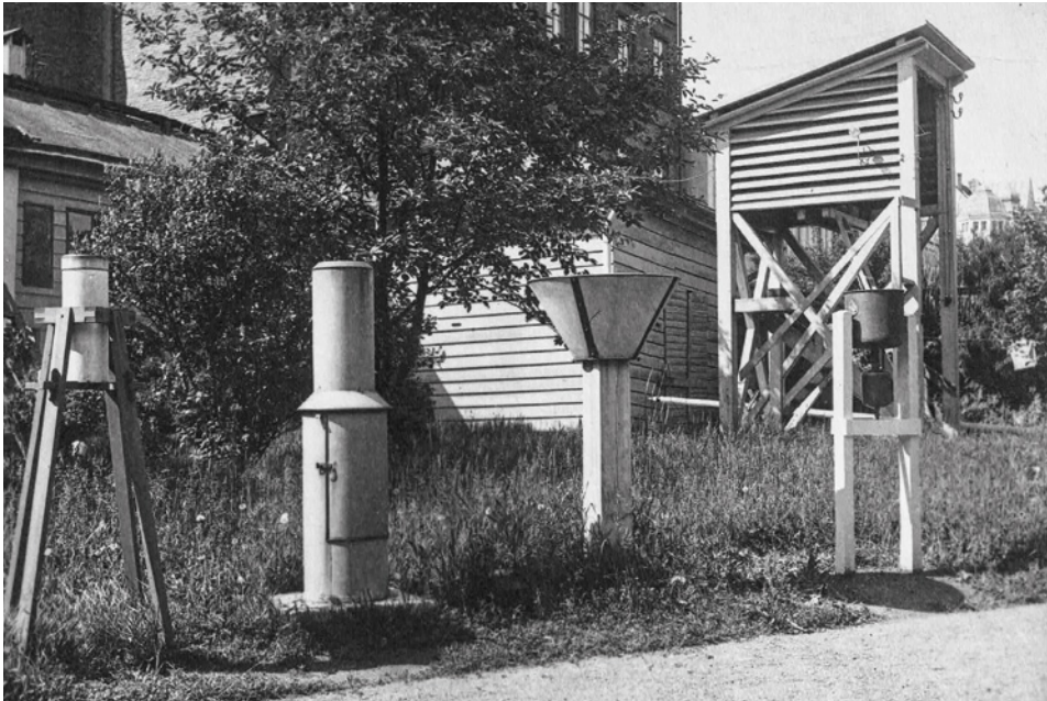
Kuva 100. Neljä sademittaria Ilmatieteellisen keskuslaitoksen pihalla Kaisaniemessä 1900-luvun alussa. Mittareista kolmas vasemmalta on Wildin sademittari, jota kutsuttiin myös isomittariksi, jollaisia oli Suomen sadeasemilla 1900-luvun alusta 1980-luvulle saakka. Sen vieressä oikealla on Helsingin magneettis-meteorologisen observatorion sademittari, joka oli käytössä vuosina 1844–1881. Vastaavanlainen sademittari oli käytössä jo Turun akatemian aikoina professori Johan Lechen sääasemalla 1750-luvulla. Ensimmäinen sademittari vasemmalla on V. V. Korhosen suunnittelema kesäsademittari (Angervo, 1948a) ja sen vieressä Fuessin piirtävä sademittari.. Taustalla oikealla on niin sanottu ranskalainen sääkoju (Kuva: Ilmatieteen laitos, Melander, 1918).
