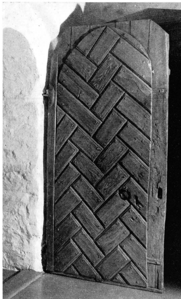
12. SAKARISTON OVI. OVILEVY LIENEE TEHTY V. 1697. Sakristiedörren. Dörrskivan torde vara gjord 1697.
