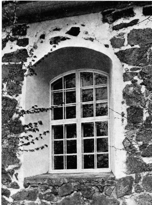
11. ETELÄSEINÄN IKKUNA. Fönster i sydvägen.
