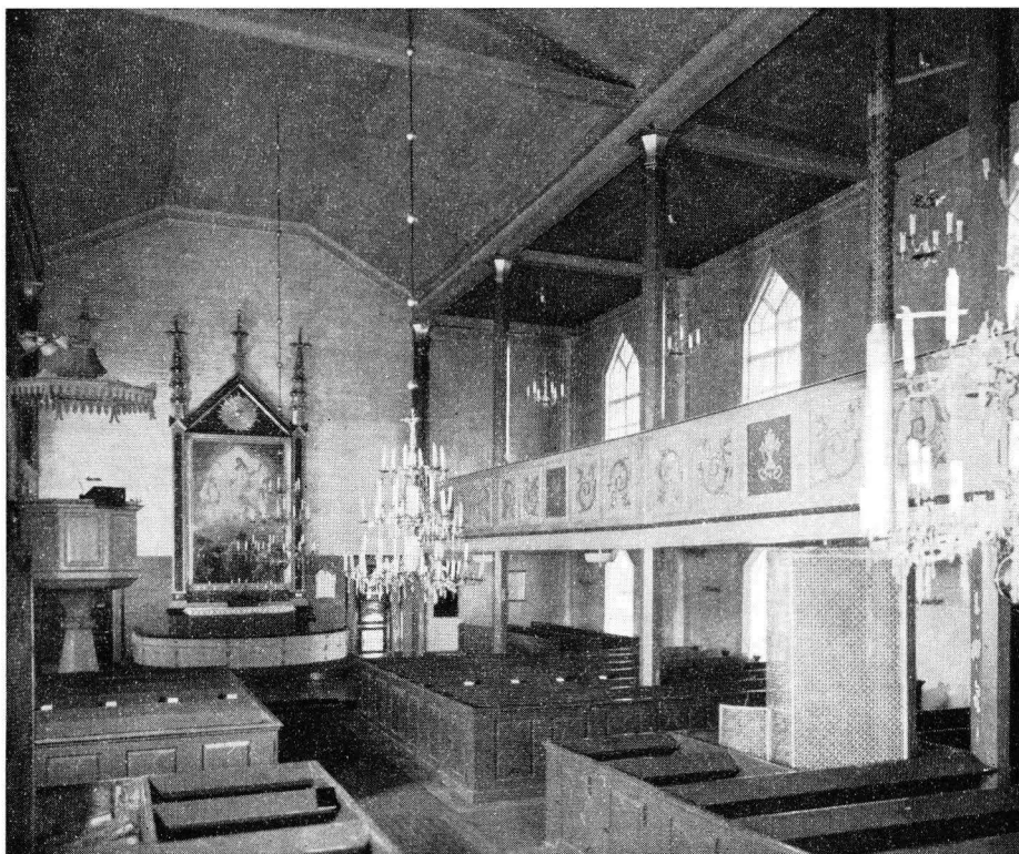
10. ITÄSUUNTAINEN SISÄKUVA. Interiör mot öster.
