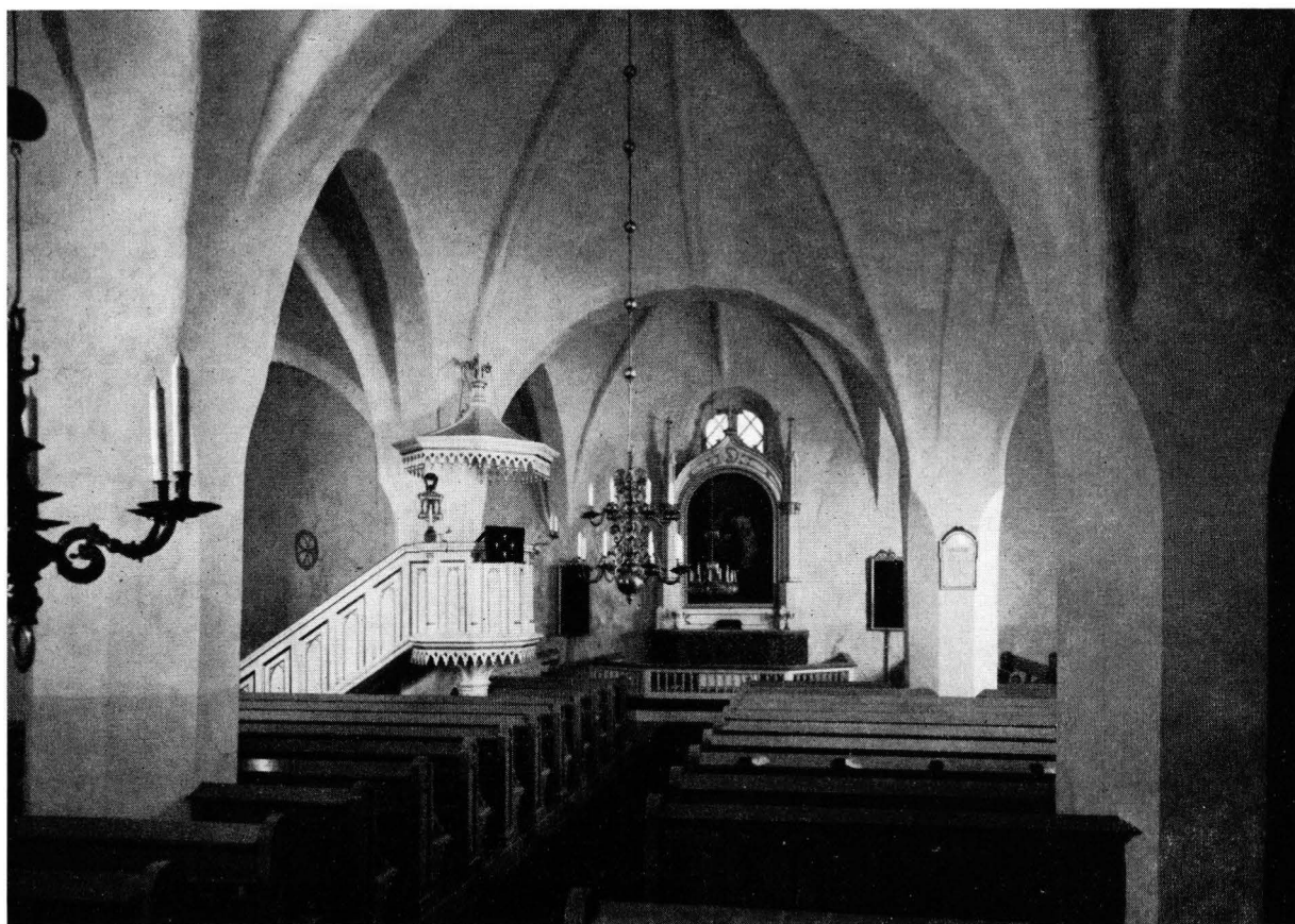
13. ITÄSUUNTAINEN SISÄKUVA. Interiör mot öster.
