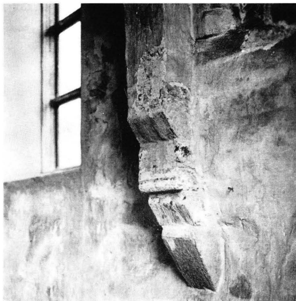
23. ITÄPÄÄDYN KALKKIKIVESTÄ JA TIILESTÄ MUURATTU KONSOLI.
