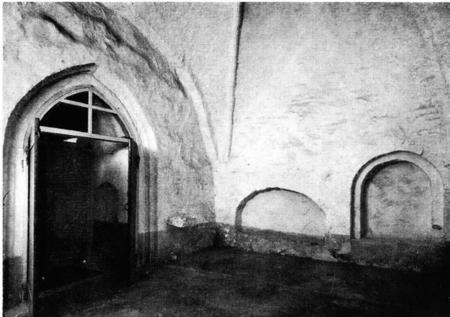
15. ASEHUONE SISÄLTÄ JA KIRKON ETELÄPORTAALI. Interiör av vapenhuset med kyrkans sydportal.
