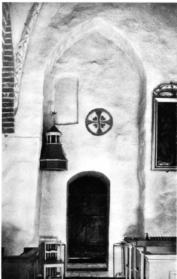
20. SAKARISTON PÄÄTY NÄKYY RUNKOHUONEEN POHJOISEINÄN KOMEROSSA.
