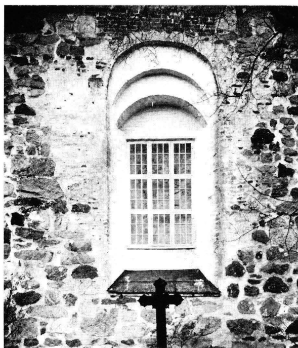
14. KUORI-IKKUNA. ALAOSAN UMPEENMUURAUKSESSA NÄKYVÄ KAHDEN TIILISAUVAN KATKELMAT.
