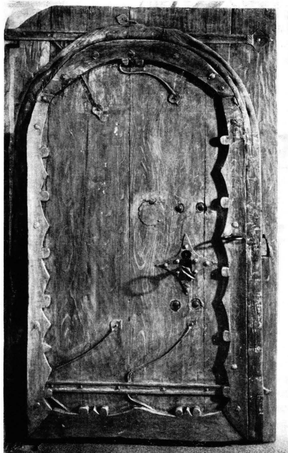
13. KESKIAIKAINEN OVILEVY SAKARISTOSTA RUNKOHUONEISEEN JOHTAVASSA OVESSA.
