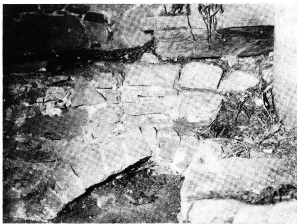
21. ALKUPERÄISEN KAKSILAIVAISEN HOLVIJÄRJESTELMÄN HOLVINJALKA NÄKYVÄ LÄNSIPÄÄDYSSÄ.
