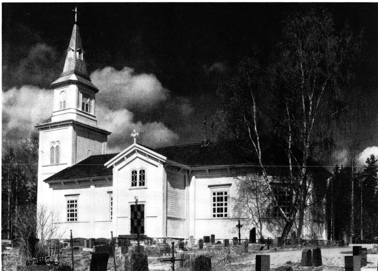
1. G. T. CHIEWITZIN PIIRUSTUSTEN MUKAAN V. 1869 RAKENNETTU KARJALAN KIRKKO KAAKOSTA. Den enligt G. T. Chiewitz' ritningar år 1869 uppförda kyrkan i Karjala, från sydost.
