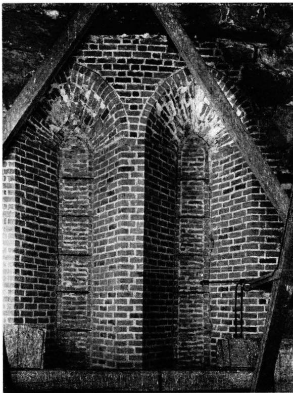
9. RUNKOHUONEEN LÄNSIPÄÄDYN UMPEEN MUURATTU KAKSOISIKKUNA, JOKA NÄKYY TORNISTA.
