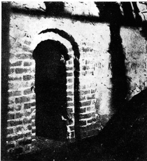
14. SAKARISTON ULLAKON ETELÄPÄÄDYN OVIAUKKO, JOKA ON JOHTANUT RUNKOHUONEEN POHJOISPARVELLE.
