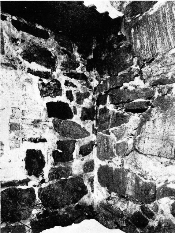
12. ASEHUONEEN JA RUNKOHUONEEN YHTYMÄKOHTA. ASE- HUONE (VASEMMALLA) ON RUNKOHUONETTA VANHEMPI. Fogen mellan vapenhus och långhus. Vapenhuset (till vänster) är äldre än långhuset.
