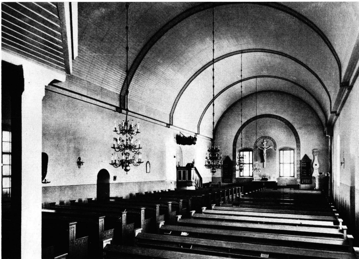
4. KIRKKOSALIN ITÄSUUNTAINEN SISÄKUVA. Interiör mot öst.
