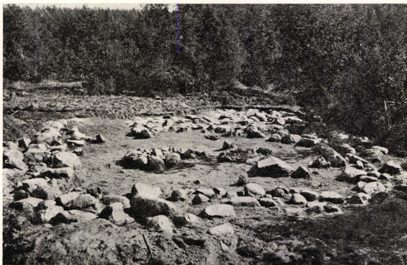
Fig. 16. Husgrund nr 5 utgrävd. Foto fr. N.
