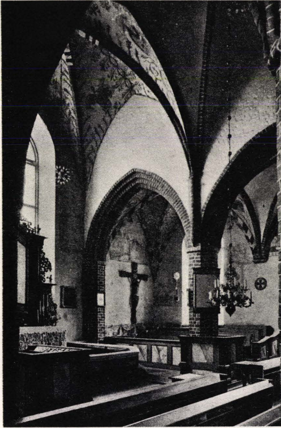
Abb. 55. Chor der Kirche von Pargas. Kolonnetten tragen die Gewölbe.
