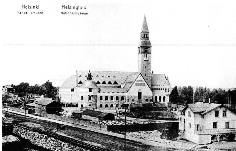
117. Gesellius, Lindgren ja Saarinen. Vuonna 1904 valmistuneiden piirustusten mukaan rakennettu kansallismuseorakennus. Rakennusvaiheen aikainen postikortti. MV, historian kuva-arkisto.
