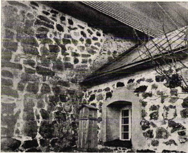
Bild 58. Pojo. Murförbandet i murväggen öster om sakristian. Foto NM.
