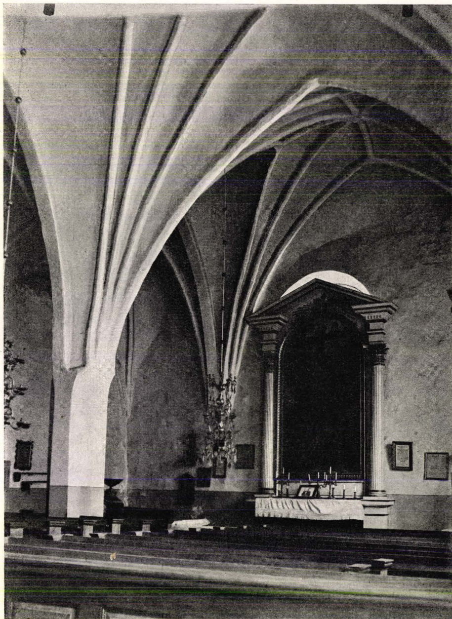
Bild 55. Pojo. Märken efter det gamla valvets anfang på kyrkans östvägg. Foto NM.
