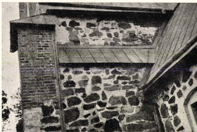
Bild 72. S. Marie. Murförstärkning i kyrkans nordvägg. Foto förf.
