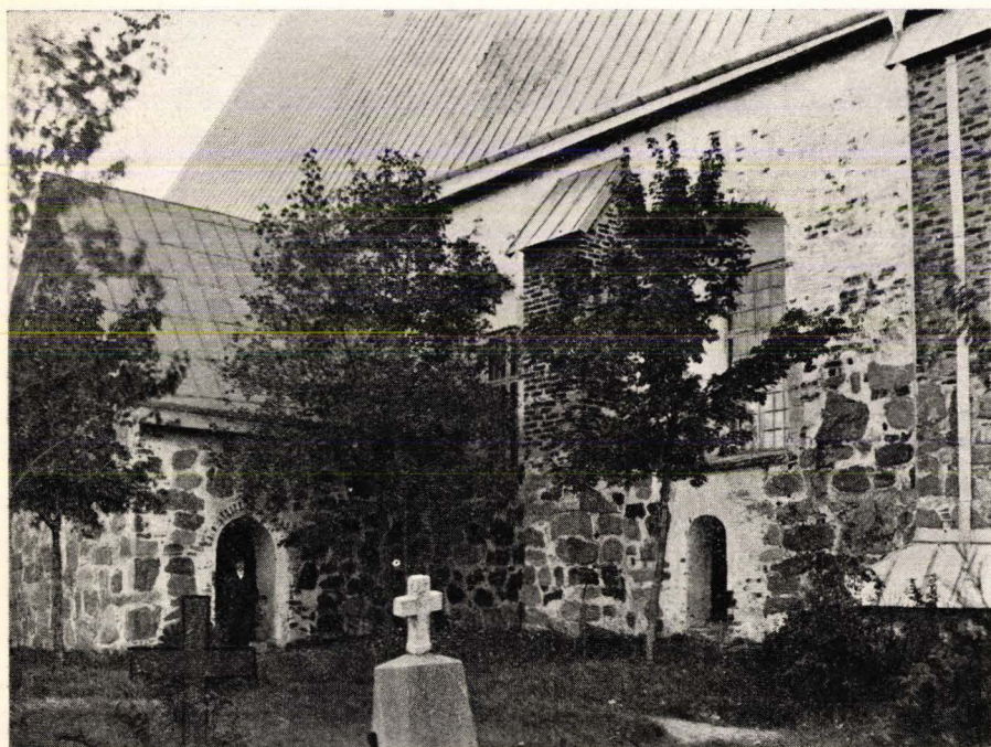
Bild 74. S. Marie. Vapenhusets östra och kyrkans södra vägg. Foto NM.
