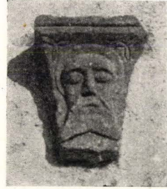
Abb. 9. Konsole an der Westfassade der Kirche zu Risti.
