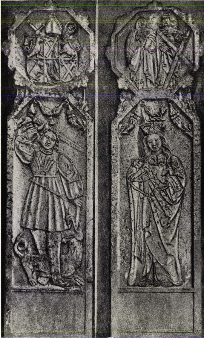
Abb. 46. Beischlagsteine der Olavs-Burse in Rostock. Nach Bau- und Kunstdenkmäler Meckenburgs.
