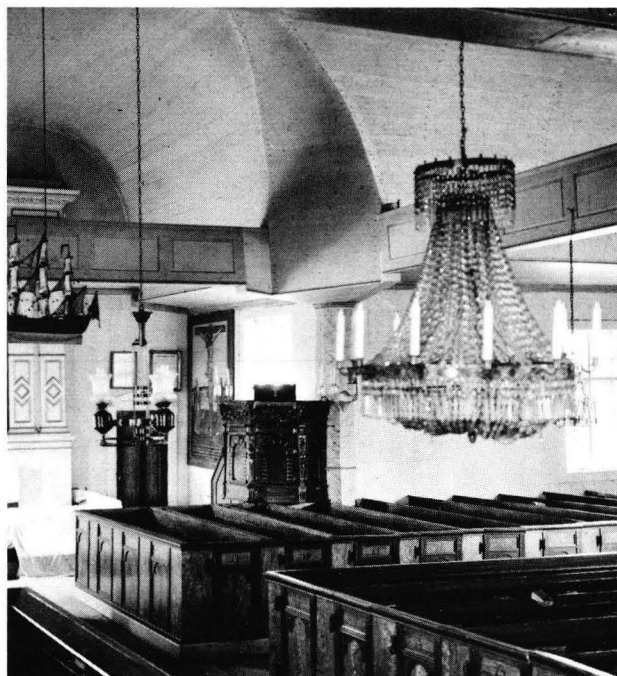
Kuva 185. Houtskarin kirkko v:lta 1703—04. Rakennusmestari- na Erik Nilsson Pohjanmaalta. Sisätila koilliseen. Valok. K.K. Meinander 1907. MVHK neg. 2611. Holvien väliset viisteet alkuperäiset. Sidehirsien ja konsolien vuoraus poistettiin v:ien 1953—54 korjauksessa.
