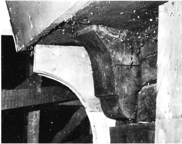
Kuva 54. Ruoveden kirkko. Luoteisviisteen ja pohjoisristin länsiseinän välisestä sisäkulmasta korjaustyön aikana väliaikaisesti paljastettu konsoli, joka kannattaa länsiseinän suuntaista sidehirttä. Valok. Arne Heporauta 1977. MVROA.
