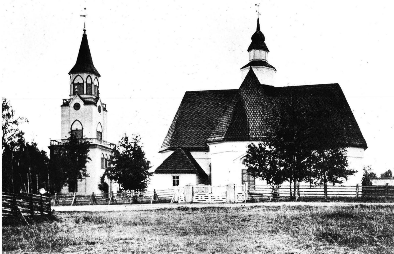
Kuva 78. Ylihärän kirkko v:ltä 1785—87. Rakennusmestarina Kaapo Hakola. Pohjoissivu. Valok. K. K. Meinander 1901. MVHK neg. 922. Kuvasta erottuu selvästi, että seinät ovat ulospäin kallellaan. Tapuli on v:ltä 1828.
