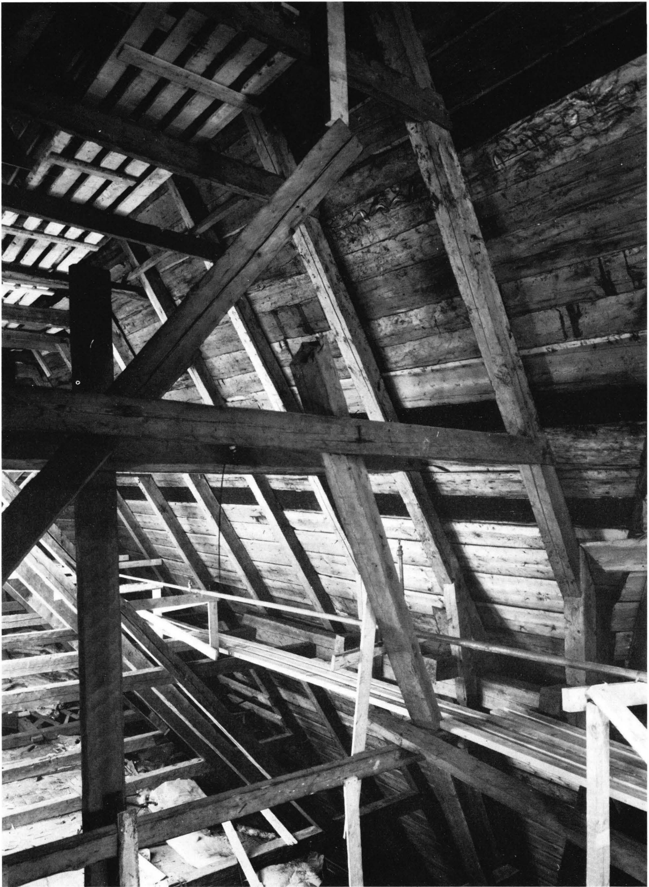
Kuva 49. Ruoveden kirkko. Länsiristin kattotuoleja lisärakenteineen luoteeseen. Oikealla ylhäällä edellisen kirkon maalauksin koristeltuja holvilautoja. Valok. P.O. Welin 1977. MVROA.
