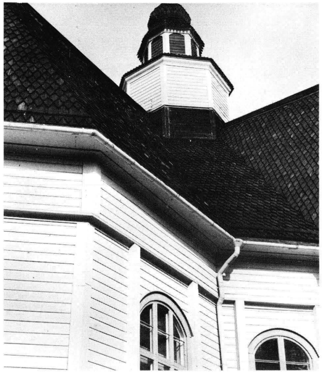
Kuva 82. Ylihärman kirkko kaakosta. Räystäät ovat sisäviisteiden kohdalla leveämmät kuin muualla kavetakseen sitten tasaisesti ristivarsien sivuseinien ulkopäitä kohti. Valok. kirjoittaja 8.9.1978.
