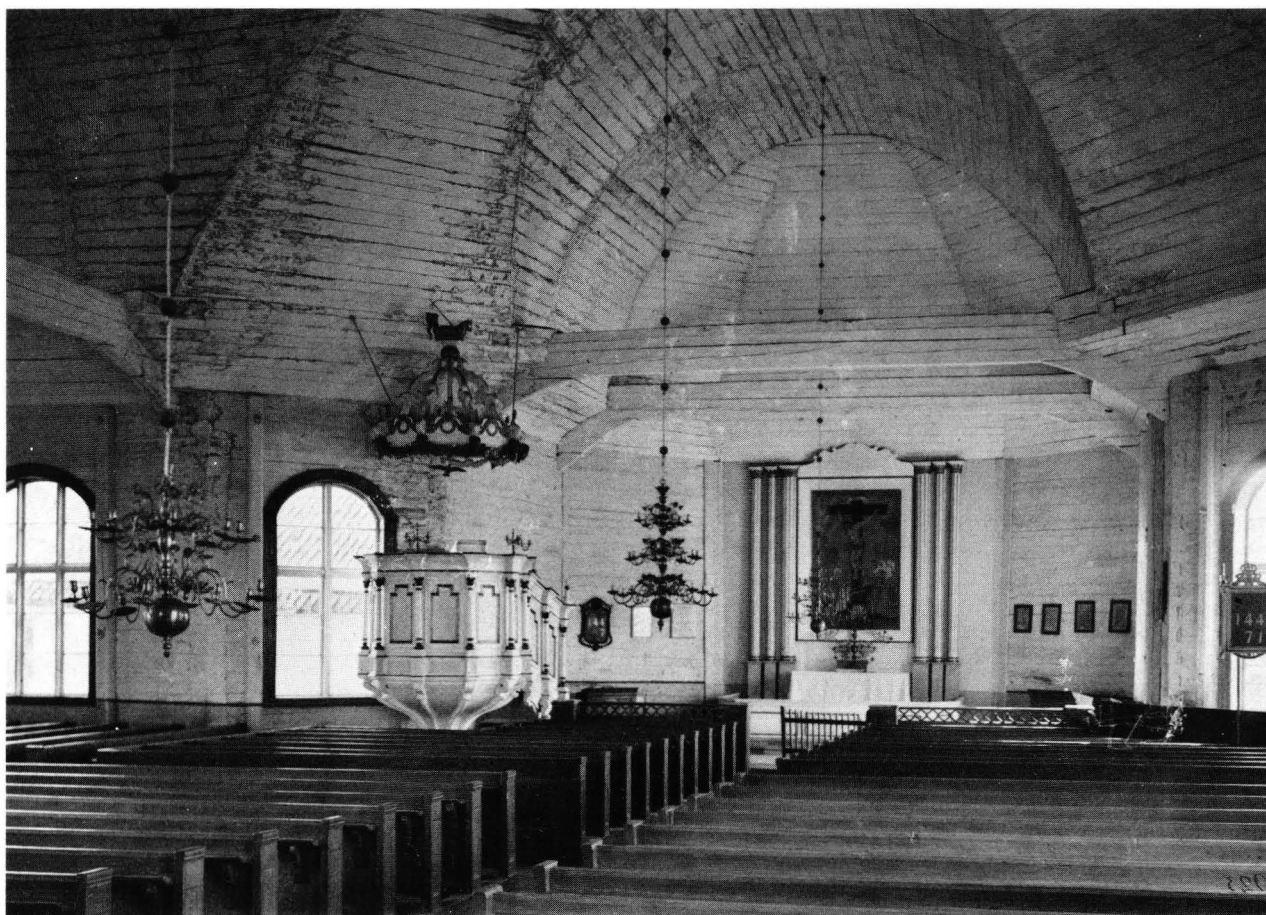
Kuva 80. Ylihärän kirkko. Sisätila koilliseen. Valok. K. K. Meinander 1901. MVHK neg. 923. Myös tämä kuva osoittaa, että seinät ovat ulospäin kallellaan.
