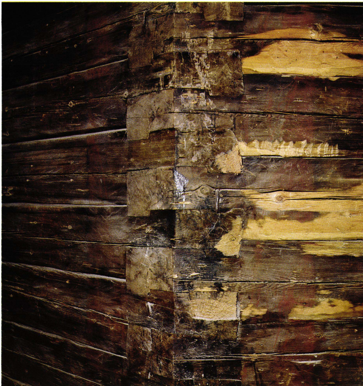
Ruoveden kirkko. Paljaana säilynyttä hirsiseinää ja vastaavia läpilukollisia lohenpyrstönurkkia itäristin kaakkoisviisteen ja peräseinän välisessä taitteessa. Valok. P. O. Welin 1978. MVROA.
