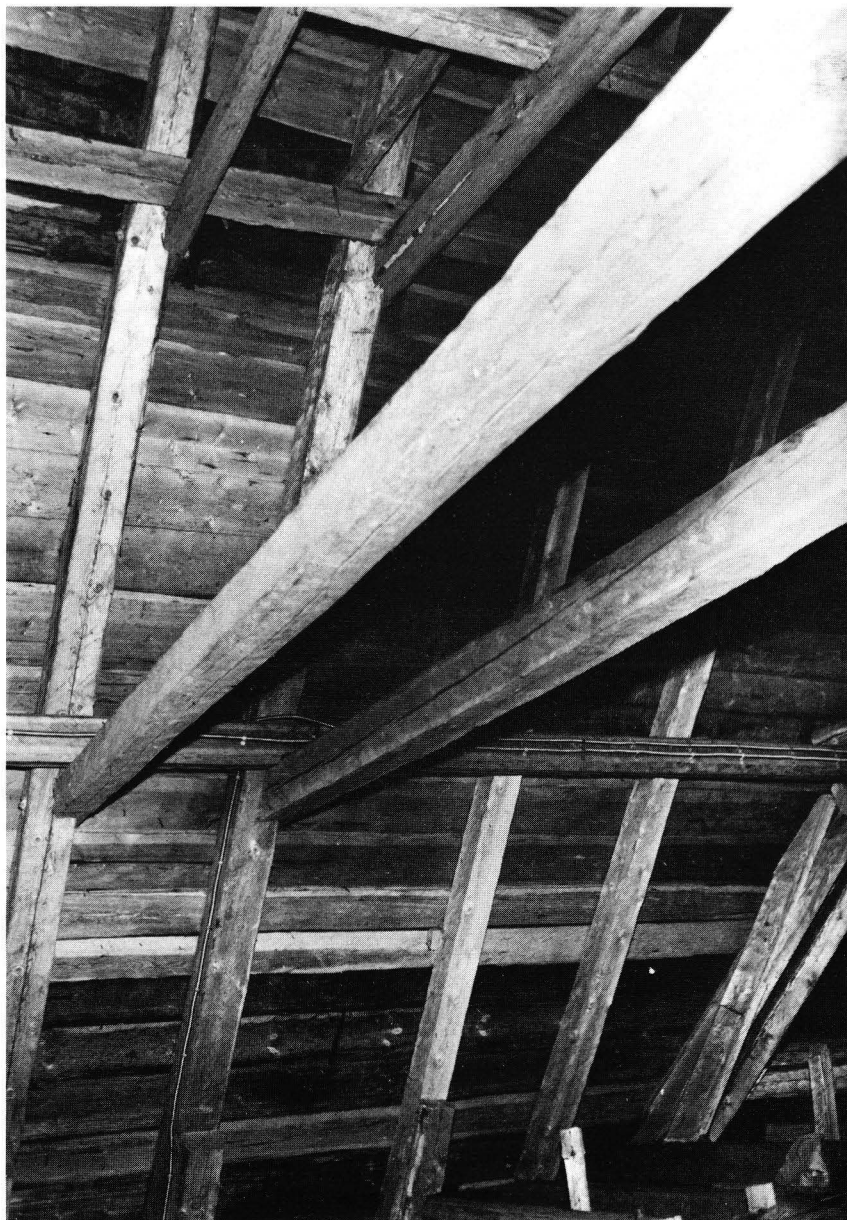
Kuva 21. Kuortaneen kirkko. Pohjoisristin kattotuoleja. Yleisku- va kaakkoon sekä lähikuva selkápuiden, vinotukien ja alimpien kitapuiden välisistä liitoksista. Valok. Paavo Valkama 6.11.1978. Vrt. kuva 112.
