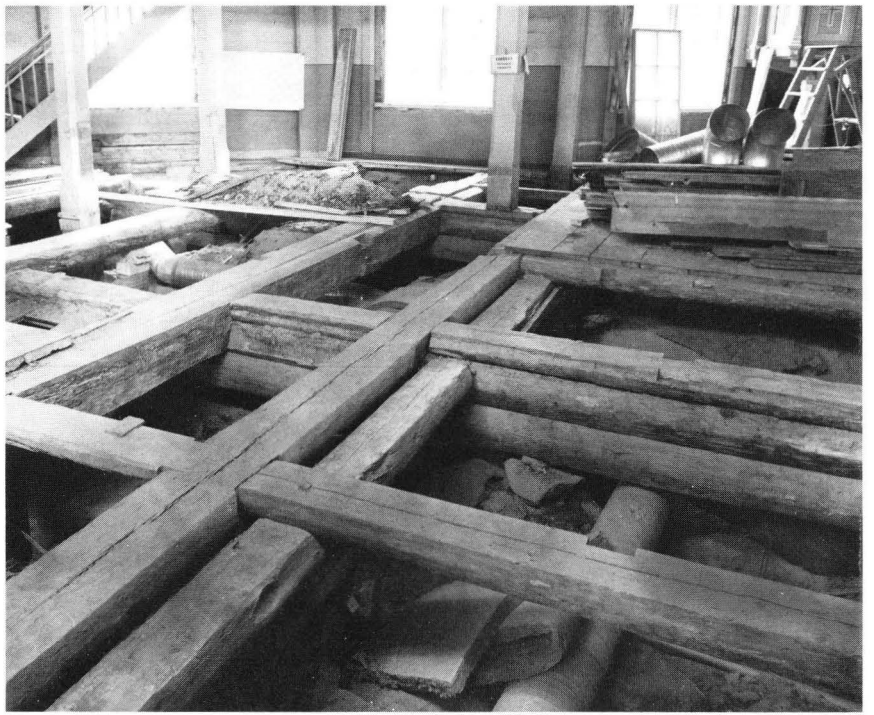
Kuva 50. Ruoveden kirkko. Lattian aluskehikko pohjoisristin ja keskitilan liittymäkohdassa koilliseen nähtynä. Vasemmalla alkuperäisen sakariston puretun eteläseinän paikka. Valok. P.O. Welin 1977. MVROA.
