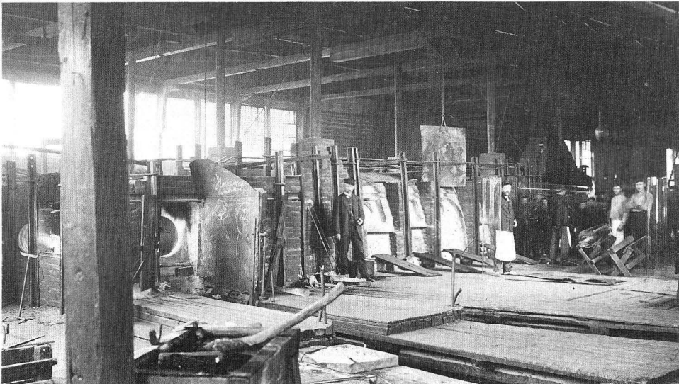
Valokuva 38. Karhulan tehtaassa lasiuuni noin vuonna 1910. Sulatus käynnissä. KLA.
