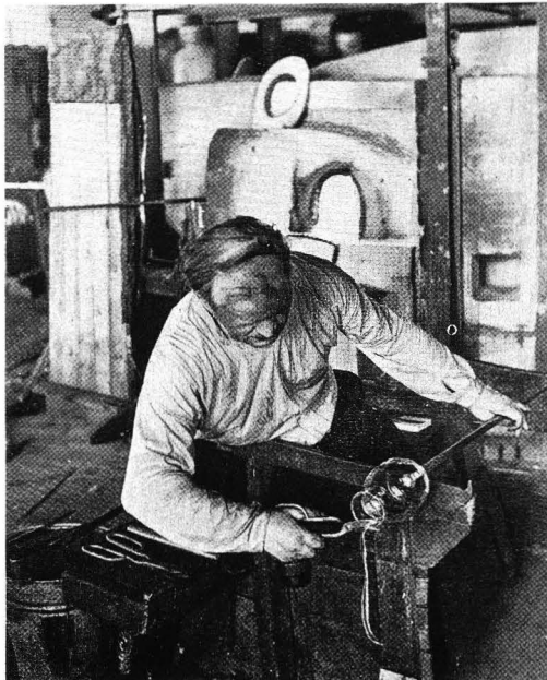
Valokuva 47. Kuumaa lasia voi leikata kuin paperia. Mestari muovaa saksilla esineen suuta. RLA.
