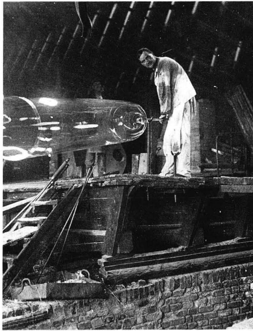
Valokuva 58. Ikkunalasivalssi on juuri valmistunut Skinnarvikin lasitehtaalla 1920-luvun alussa. SLM.
