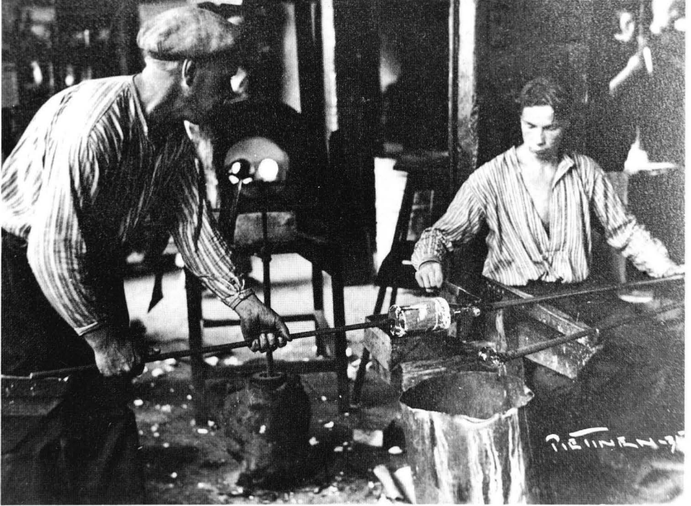
Valokuva 50. Puhaltaja irrottaa pillistään pullon, jota kantopoika (vas.) kannattaa punttelilla Riihimäen Lasi Oy:ssä vuonna 1935. Valok. A. Pietinen. RLA.
