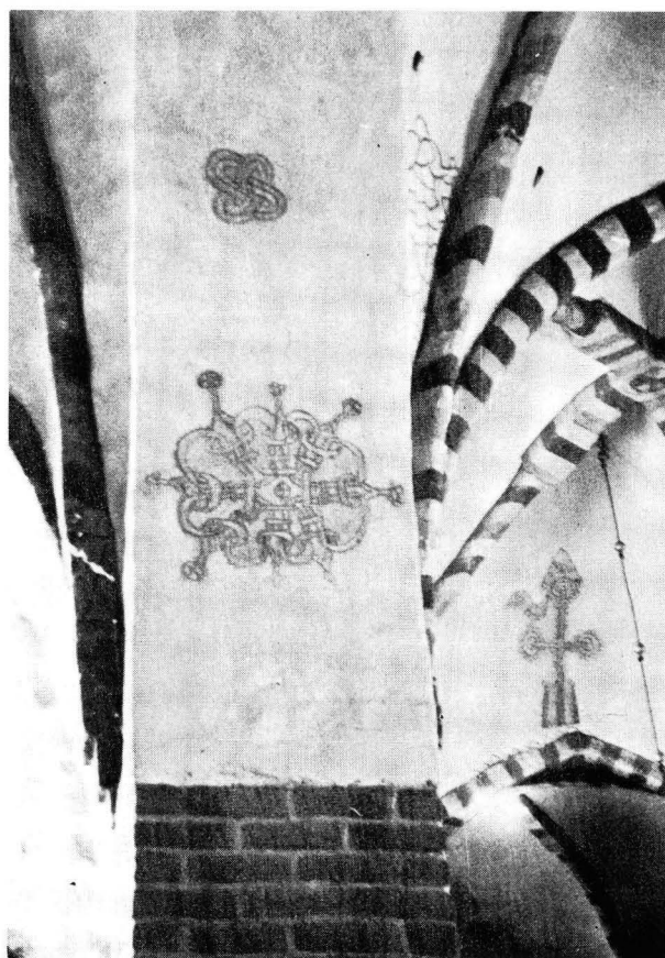
Bild 36:2. S. Marie kyrka. Sydskeppets tredje arkadbåge, sedd mot väster. Foto: Stigell 1970.
