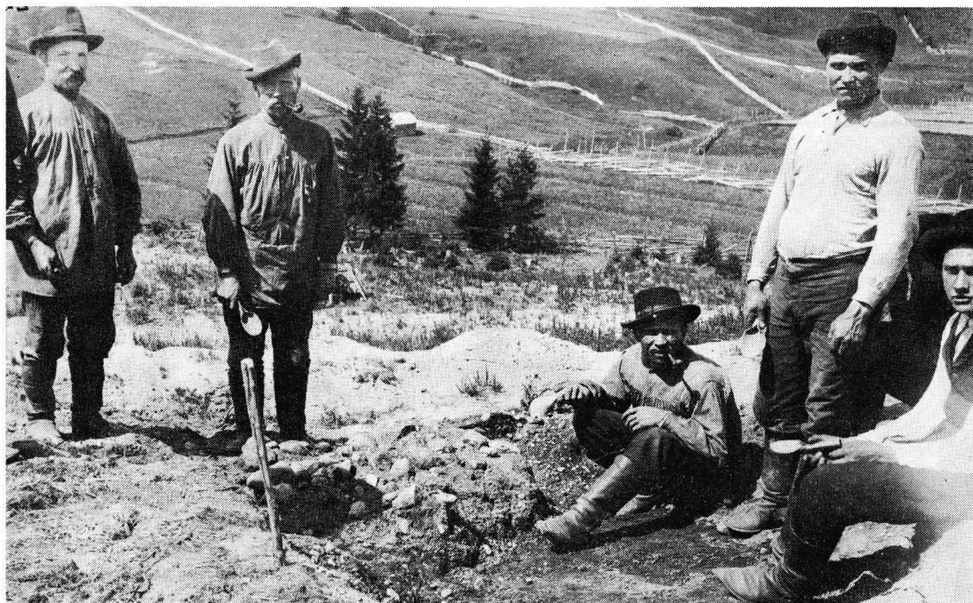
Fig. 48 Från grävningarna i Jäkrlä. Fotografi B. Cederhvarf 1908.
