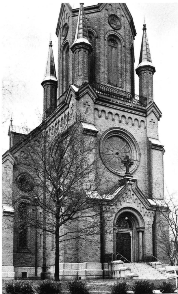
Bild 45. Västfasaden i Alexanderskyrkan i Tammerfors. Foto P. O. Welin 1978. MVHBA.
