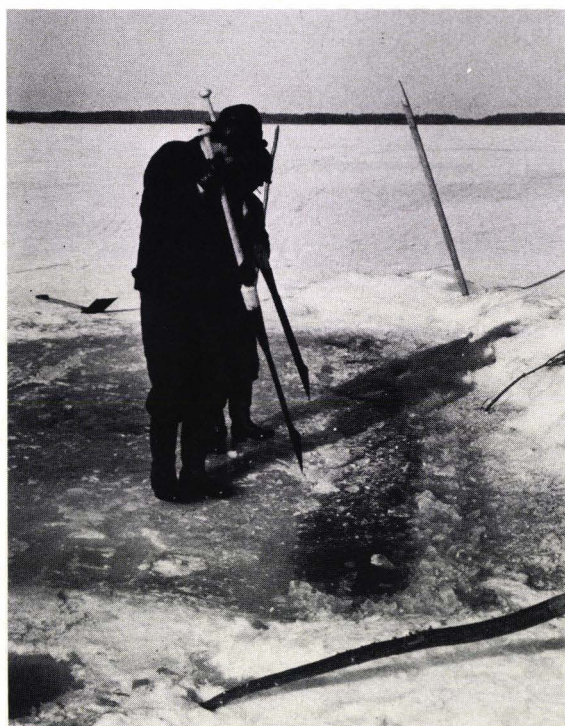
Kuva 146. Polviavannolla uittomies on kietaissut köyden viehkan taakse, jotta avantojen mutkan kohdalla ei köysi karkaisi jään alle saavuttamattomiin. Viehkoilla on merkitty polviavantojen paikat.
