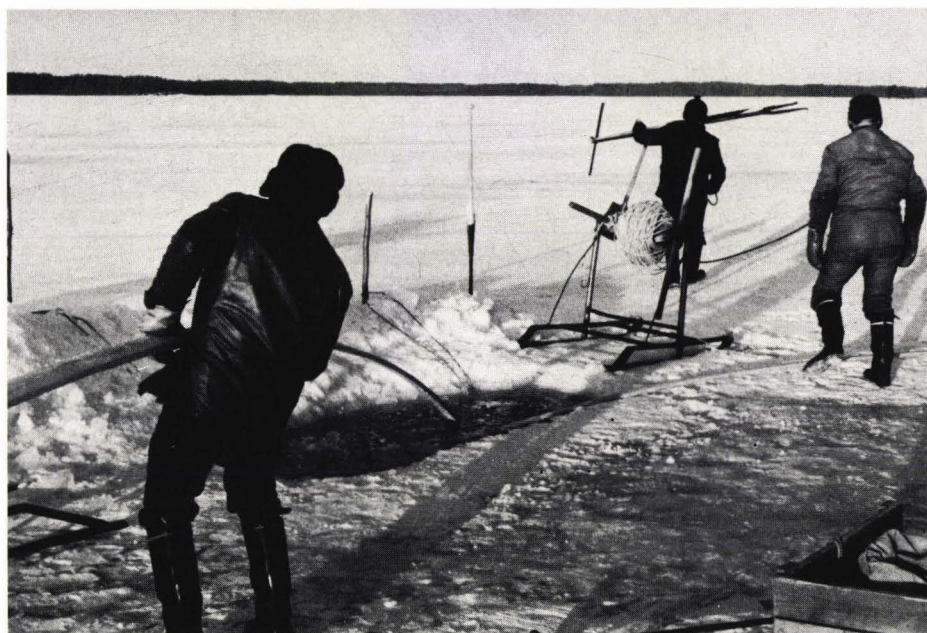
Kuva 117. Kun laskin on auki, työnnetään uittosalot jään alle. Uittomies lähtee hankoineen ja kokkineen väliavannoille.
