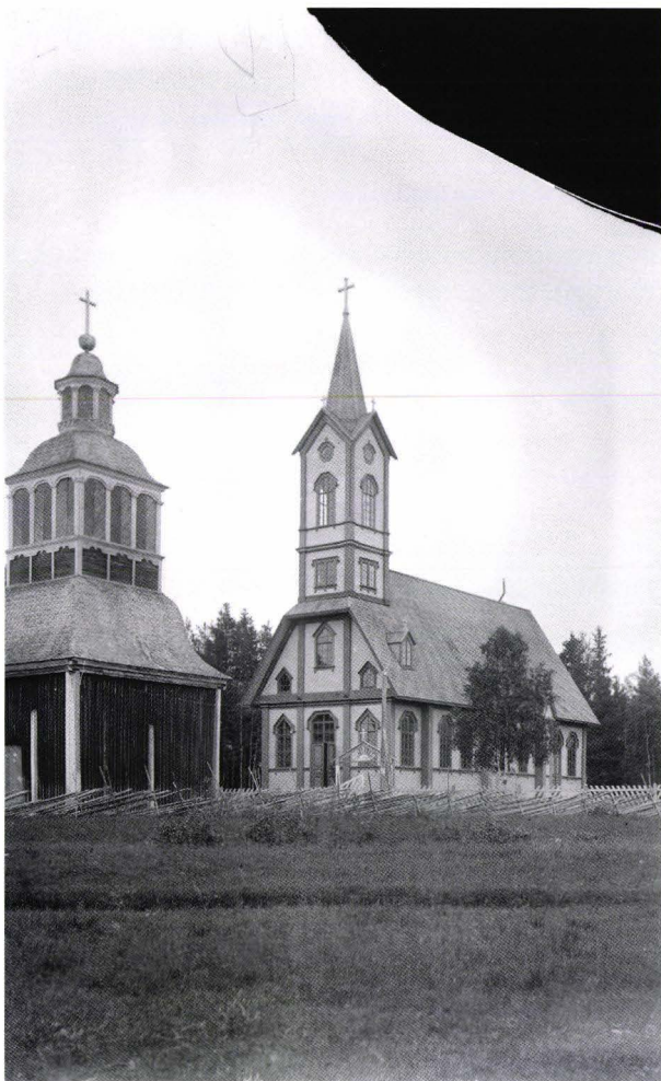
KUVA 74. Utajärven länsitornillinen pitkäkirkko sai vuoden 1893 korjauksessa lääninarkkitehti Julius Basilierin suunnitteleman koristeellisen uusgoottilaisen ulkoasun. Retkikunnan ottama valokuva. Museovirasto.
