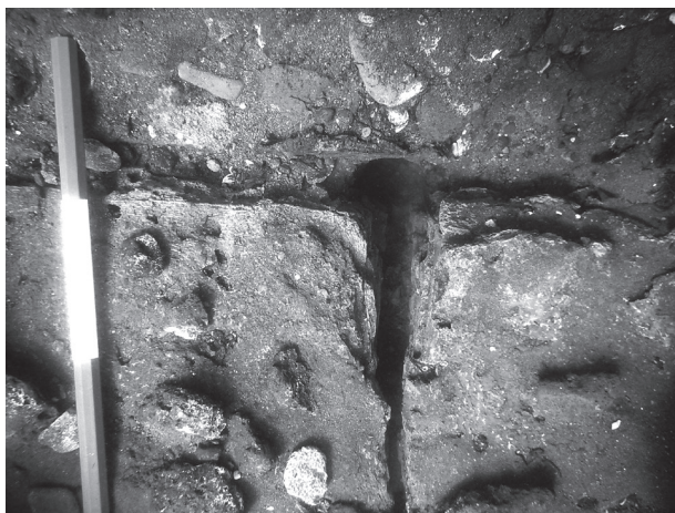
Fig. 6: Il limite di gettata tra tre moduli adiacenti con conservati alcuni residui lignei del tavolato.
