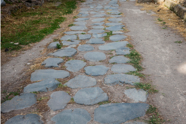
Figure 4. The lava paving of an Ostian street. Photo: Saana Säilynoja, Vapriikki Photo Archive.
